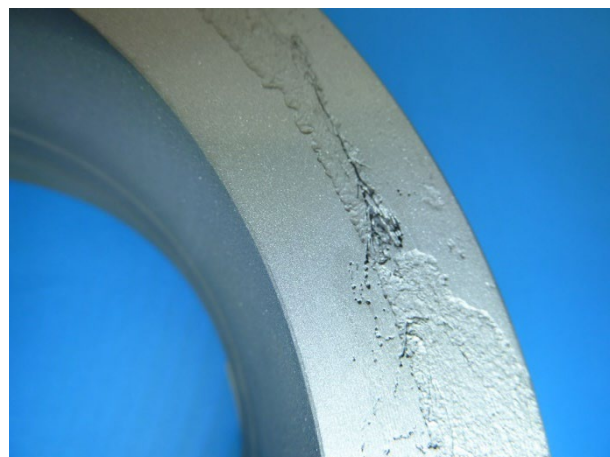
【写真7】エルボ側フランジ ブラスト後 内面
