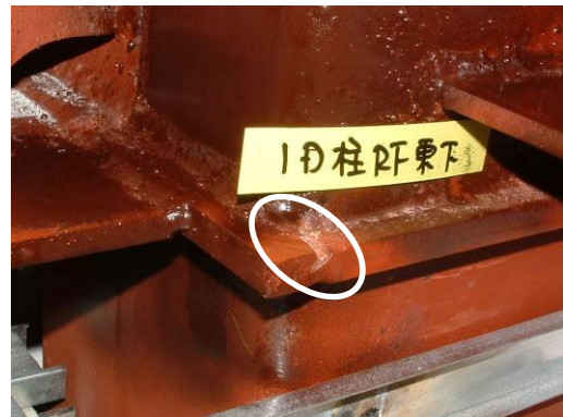
1 D柱 R階 東南面 下側
