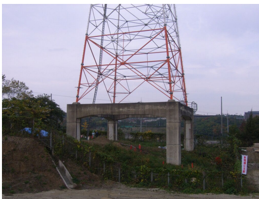
鉄塔基礎全景
