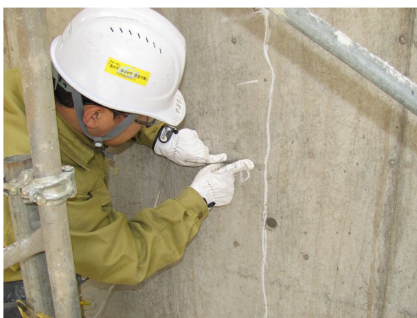
ひび割れ幅計測状況
