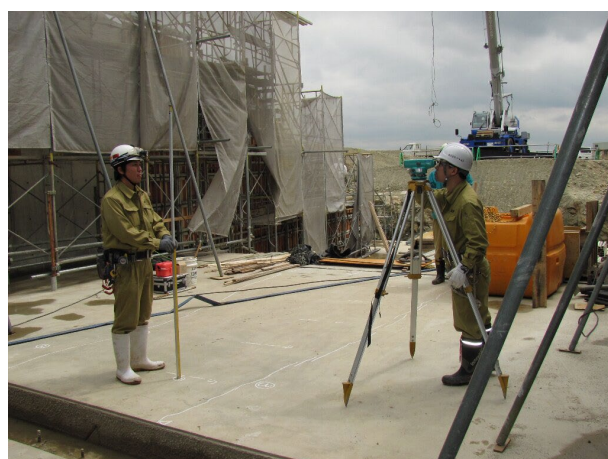
底版レベル測定状況
