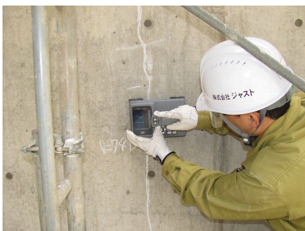
鉄筋探査状況
