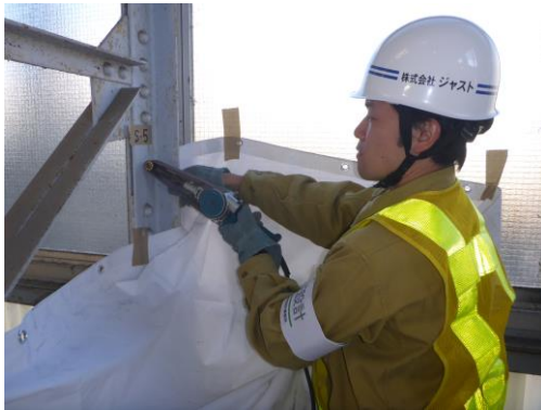
ベルトサンダーによる研磨
