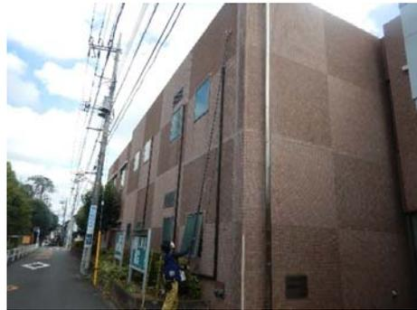
連続打音検査装置による打診状況
