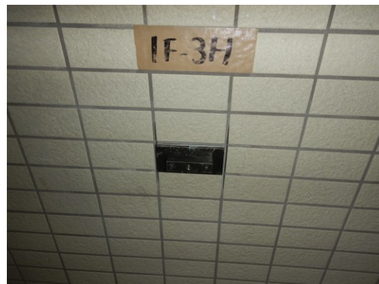
アタッチメント取付け後
