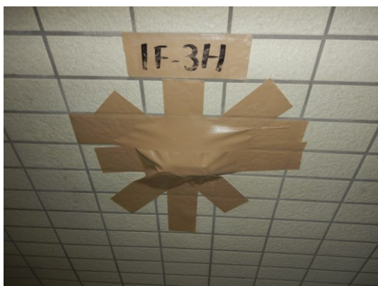
アタッチメント養生
