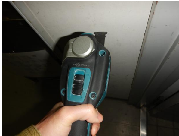
切断作業状況
