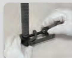
③ 変位計取付けステーをセット
