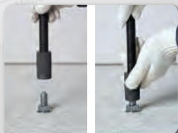
② アンカーの径に合わせてカップリングをセンターシャフトに取り付け、アンカーにねじ込む
